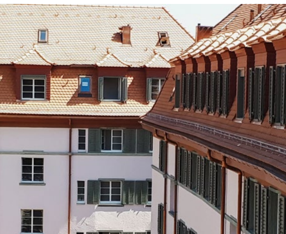
Die Denkmalpflege legte grossen Wert auf den Erhalt der Dachkonstruktion und die Gestaltung der Lukarnen. Diese mussten allesamt detailgetreu erneuert werden.
