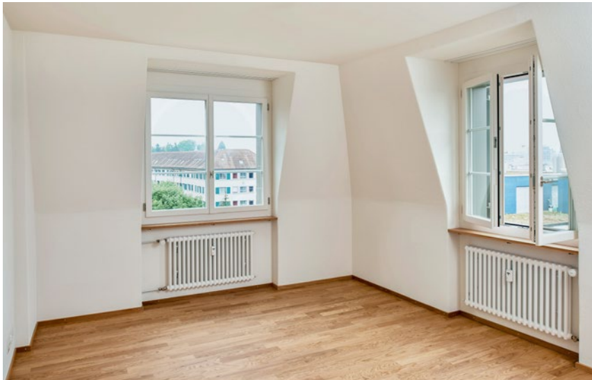
Saniertes Zimmer im Dachgeschoss. Die Böden und die Decken in den Häusern sind neu gedämmt und bieten besseren Schallschutz als früher, allerdings nicht auf Neubauniveau.
