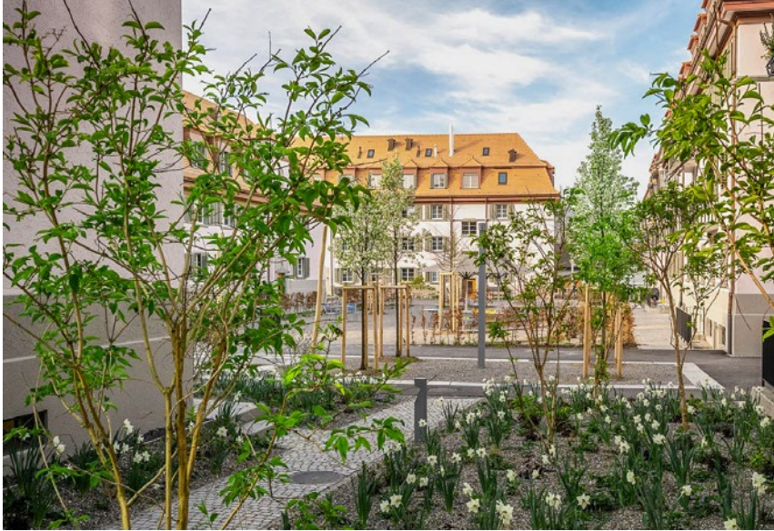
Auch der Hofbereich wurde neu gestaltet. Er lehnt sich an die ursprüngliche Situation an. Durch eine neue unterirdische Velogarage gewann man mehr Aussenraum. Im Untergeschoss wurde zudem ein neuer Gemeinschaftsraum geschaffen.
